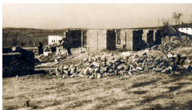
Сл. 3. Изградња темеља и камених зидова ситамбеној насеља Хидројтехничкој инсталиације током 1952–1953. Извор: фото-документација из архиве Хидројтехничкој инсталиације
